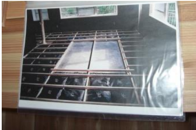
フローリング下に床下調湿炭敷き設
