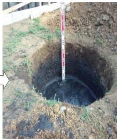
高機能無機炭投入、水でしめ、土を埋め戻します。
